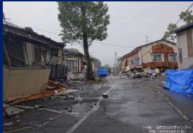
▶ 益城町の住居倒壊被害
